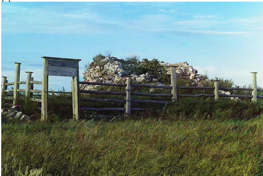
Рисунок 3. Разрушенный вид мавзолея Хусейн-бека
